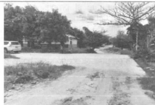
13.Vista general de la Obra
