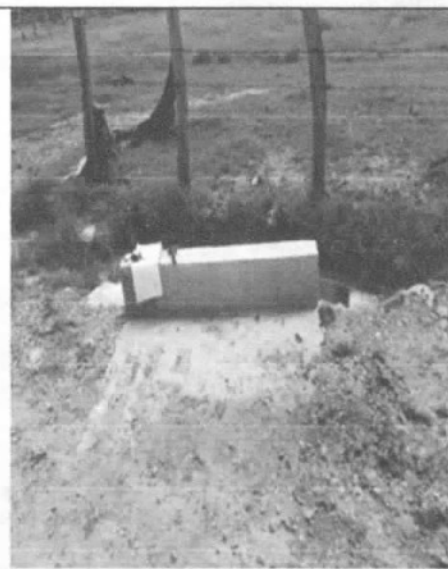
2. Detalle de zona superior del box culvert
