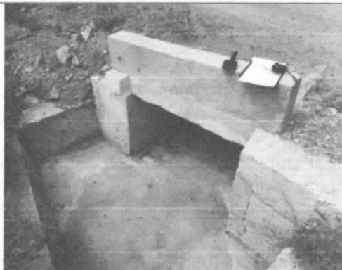
3. Costado inicial de la Obra
