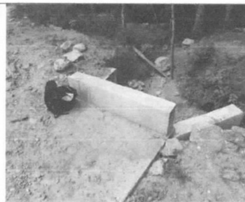
6. Descole del box culvert
